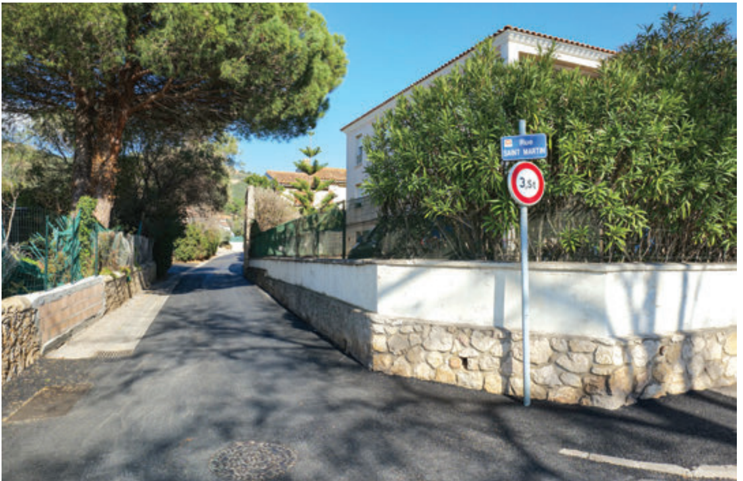
RÉHABILITATION DE LA RUE SAINT MARTIN
